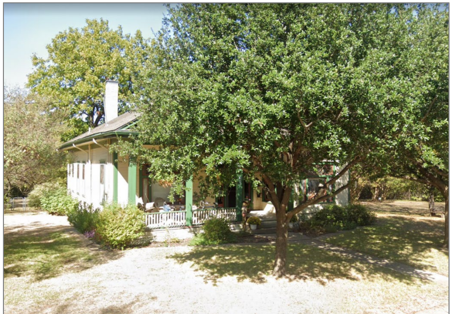
FIGURE 1: 601 N. FANNIN STREET
